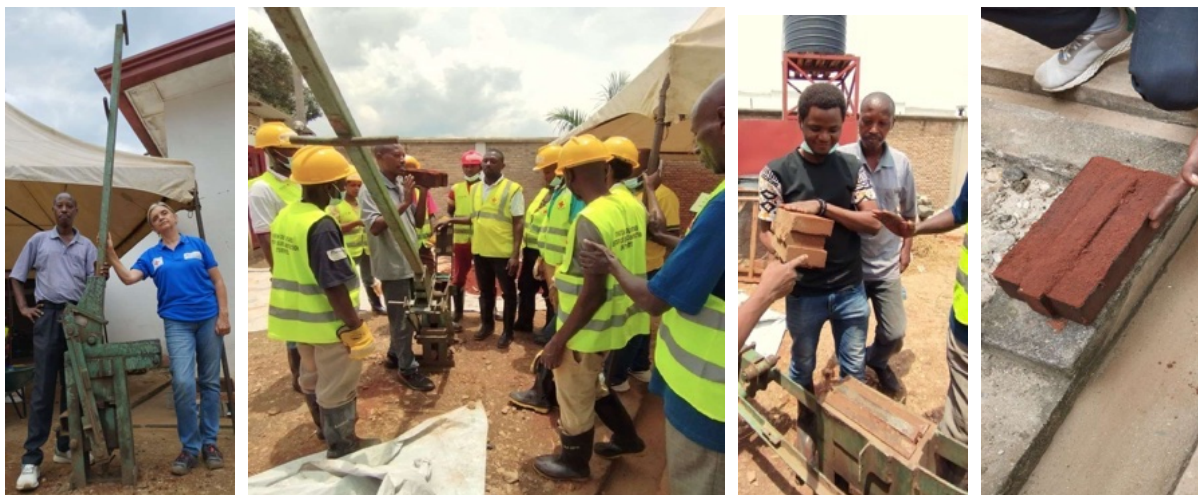
Alternatives possibles : presses de fabrication locale et transportables, BTCs encastrables
