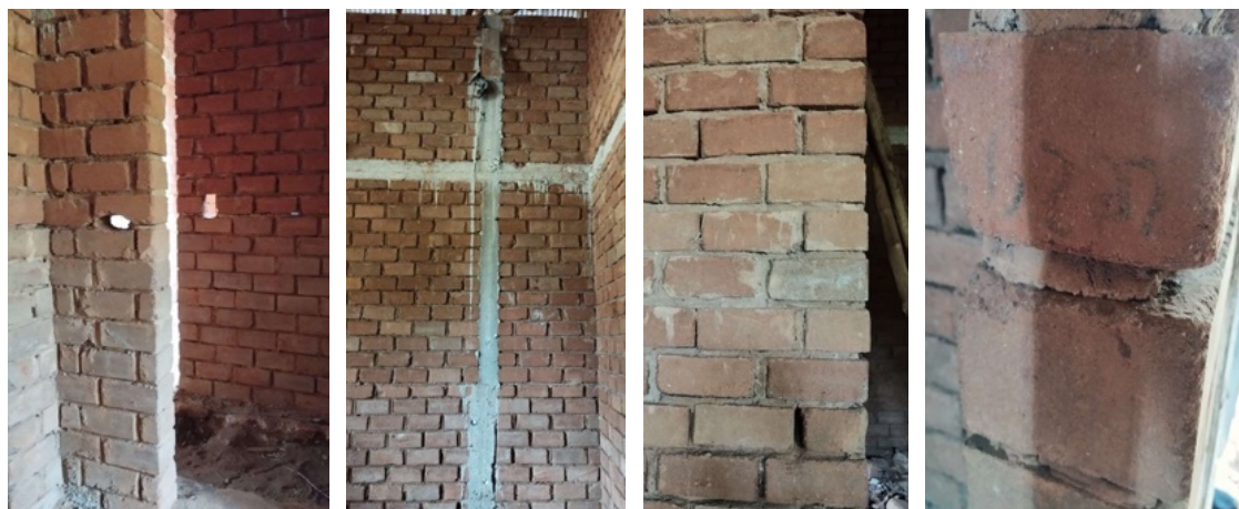
Un cumule de mauvaises pratiques impropres de la maçonnerie en BTC -dont un de ses atouts est la visibilité
